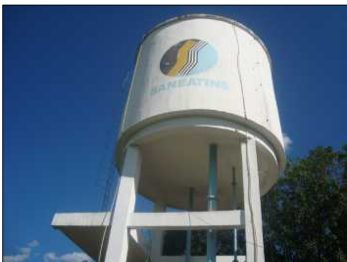
Figura 7. Reservatório Elevado (REL).
