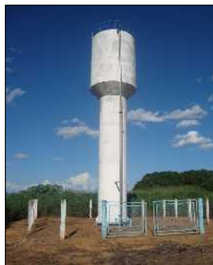
Figura 8. Reservatório Elevado (REL).
