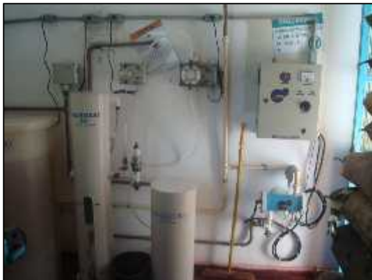
Figura 5. Casa de tratamento – Araguaçu.
