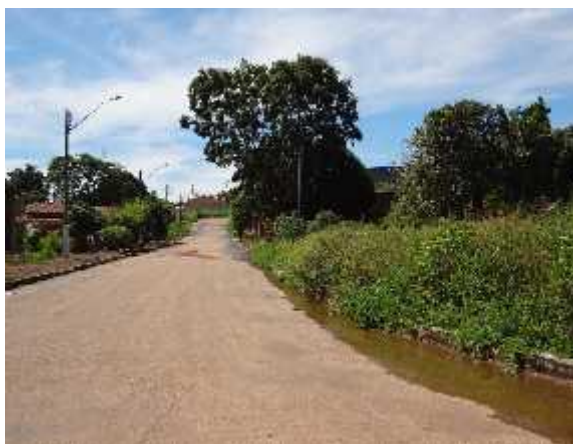
Figura 18 - Erosão parcialmente contida
