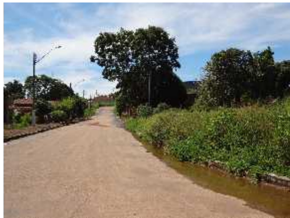
Figura 17 – Alagamento permanente - Afloramento do lençol subterrâneo
